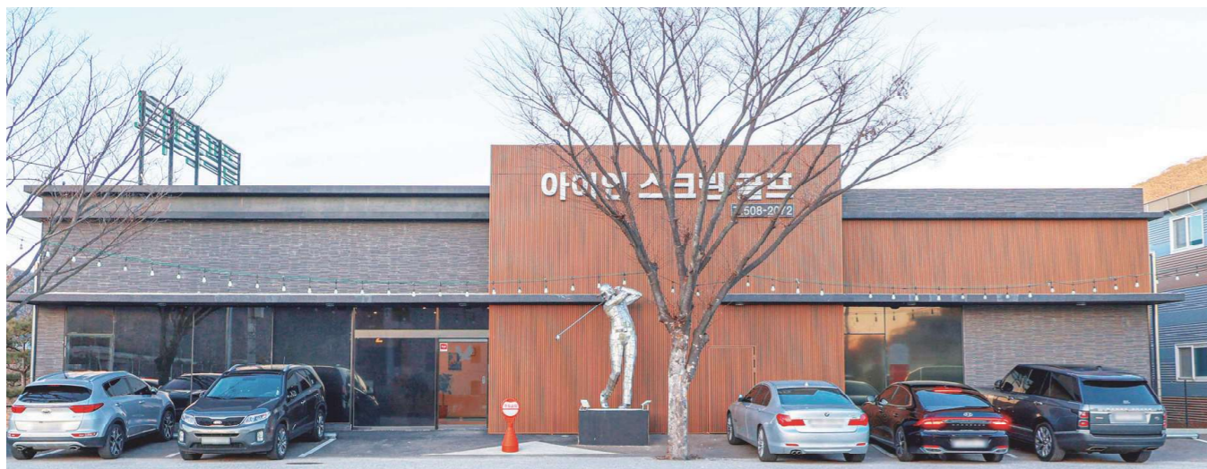
기장군 스크린 골프장 건축
